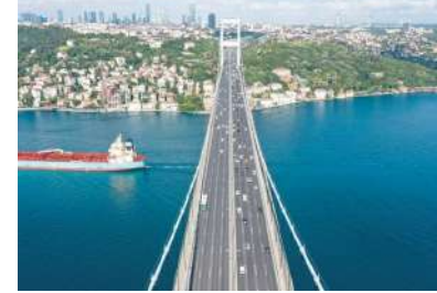
FSM Köprüsü 27 km
